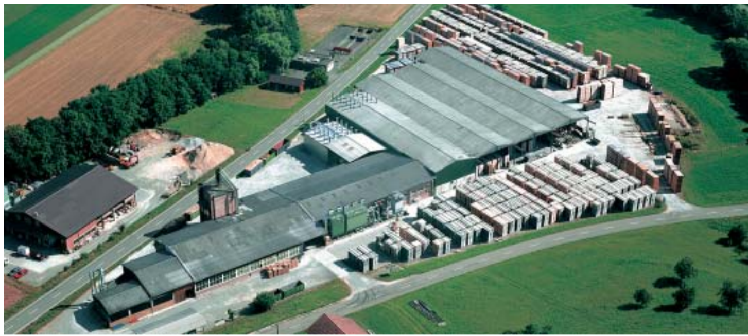
Beispiel für eine gelungene Umnutzung: Im Sommer 2006 wurde das Areal der Bauwerk Parkett AG in Wittnau SG einer neuen Verwendung zugeführt.
